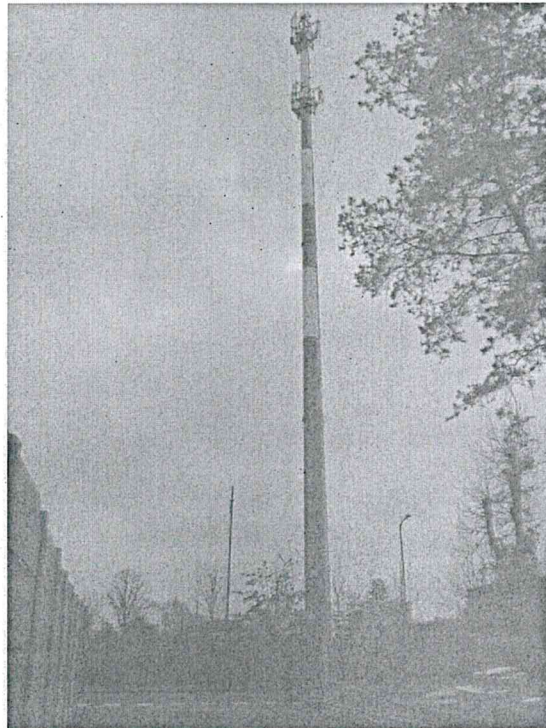
Zał. nr 1: Widok ogólny instalacji radiokomunikacyjnej.
