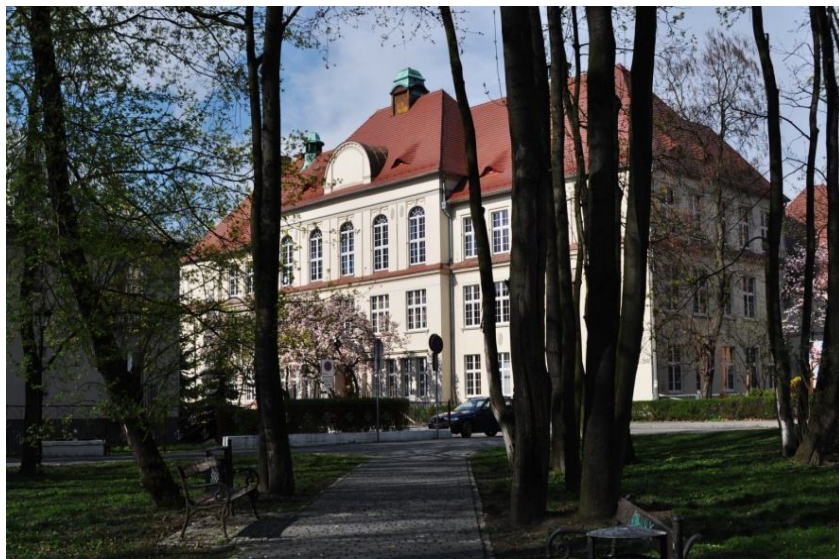
Fot. 3. Widok budynku I Liceum Ogólnokształcącego po odnowieniu.
