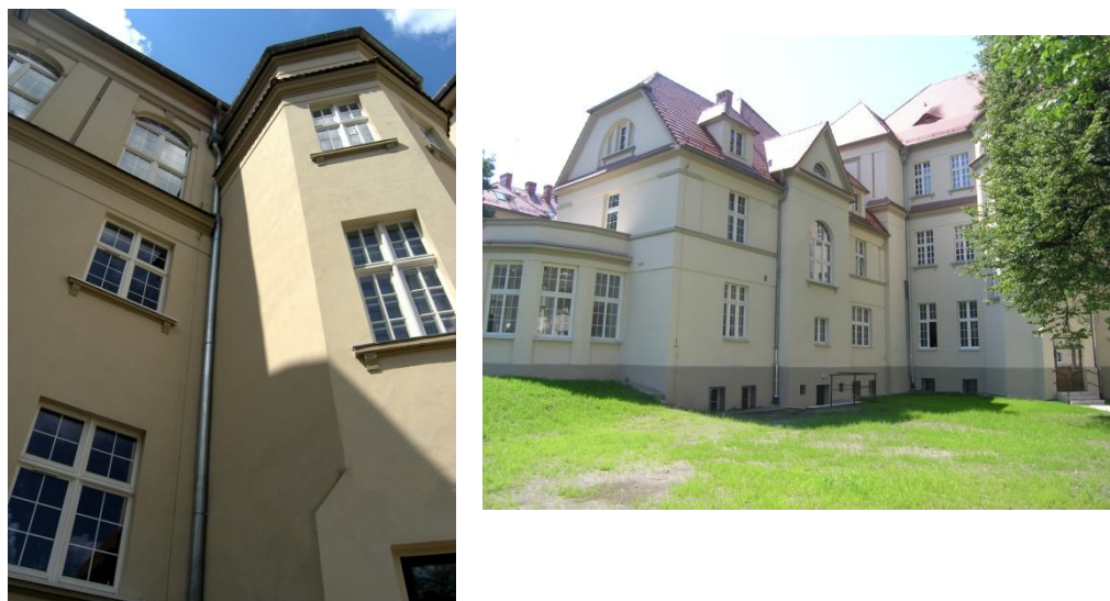
Fot. 2. Elementy elewacji budynku I Liceum Ogólnokształcącego wskazane w zestawieniu na rys. 1 po odnowieniu.
