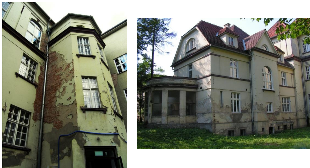
Fot. 1. Zestawienie elementów elewacji budynku I Liceum Ogólnokształcącego przed odnowieniem.
